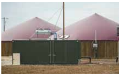
2 digesteurs VALBIO METHAMIX de 1600 m 3 et 1300 m 3
