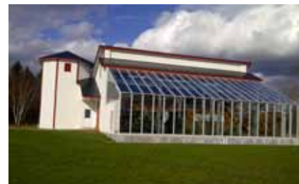
1 digesteur VALBIO METHACORE® de 60 m 3
