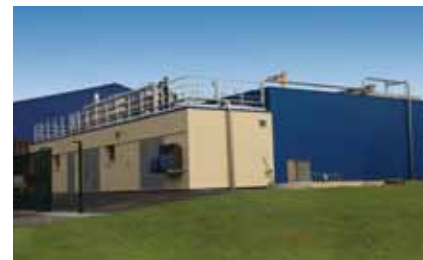
1 digesteur VALBIO METHACORE® de 750 m 3
