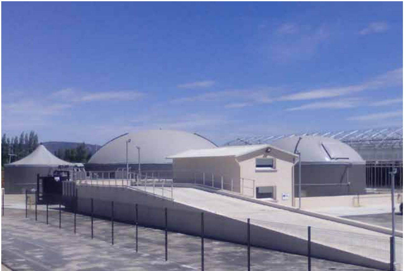
1 digesteur VALBIO METHAMIX, TAMISIER Environnement, L'Isle-sur-la-Sorgue, France (84)
