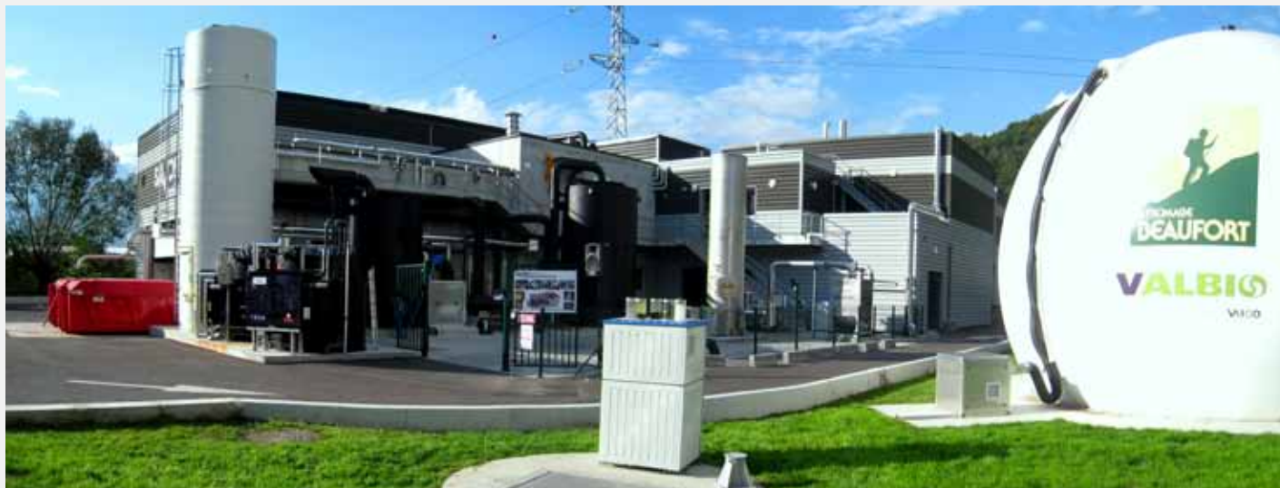
2 digesteurs VALBIO METHACORE® de 700 m 3
