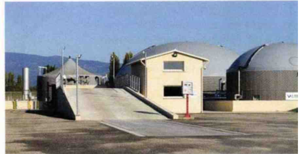
Les 900 000 Nm 3 de biogaz seront valorisés à l'aide d'un moteur de co-génération en 1,9 million de kWh d'électricité.
